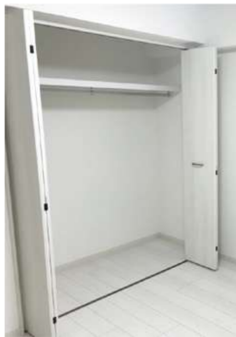
固定された枕棚+パイプ
