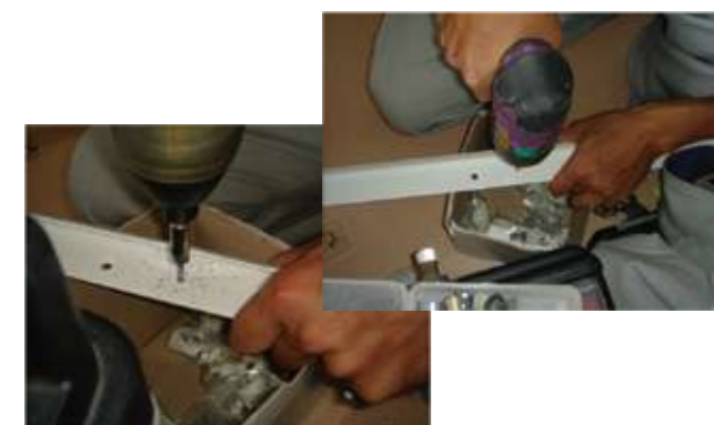
工程2: 必要位置に下地がない場合レールに穴をあける。
